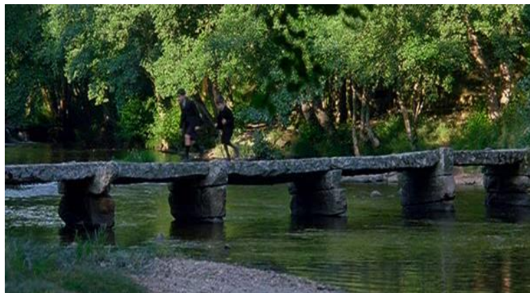
Segunda travessia da ponte.
